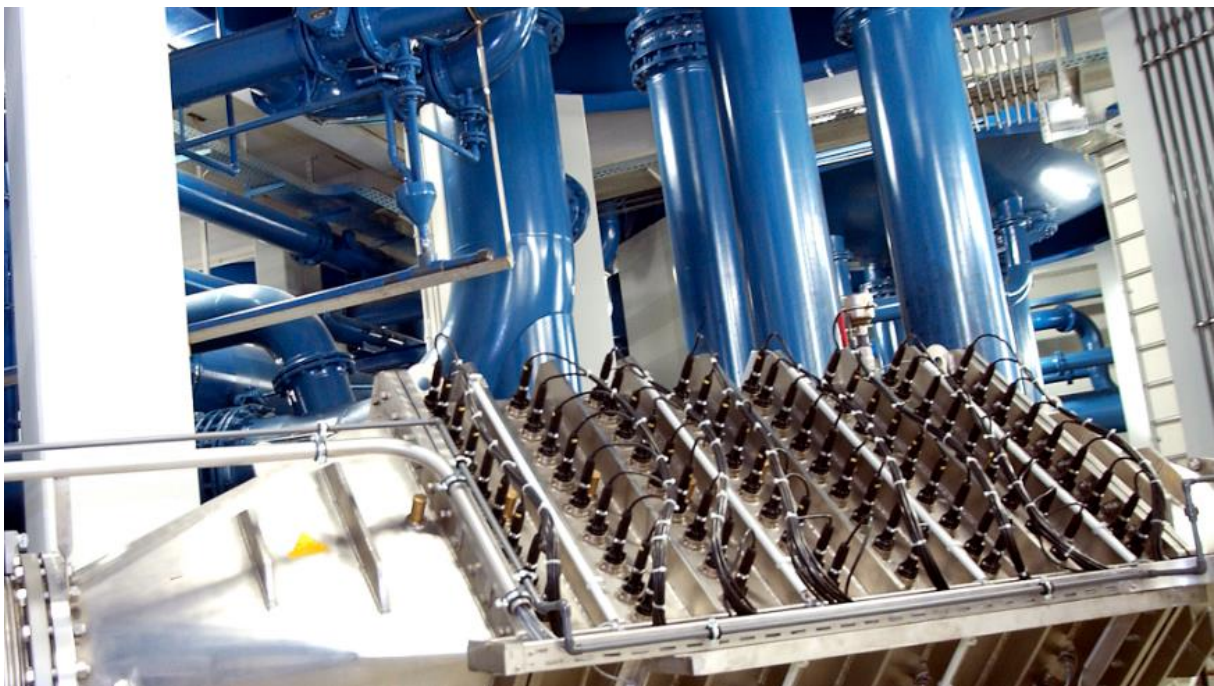
Bild: Blick auf einen UV-Strahler im Wasserwerk Styrum/Ost
